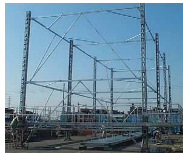
炉内点検補修用セーフティステージ
